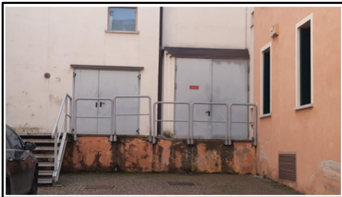
Figura 3 - ingresso palcoscenico tecnici e materiale
