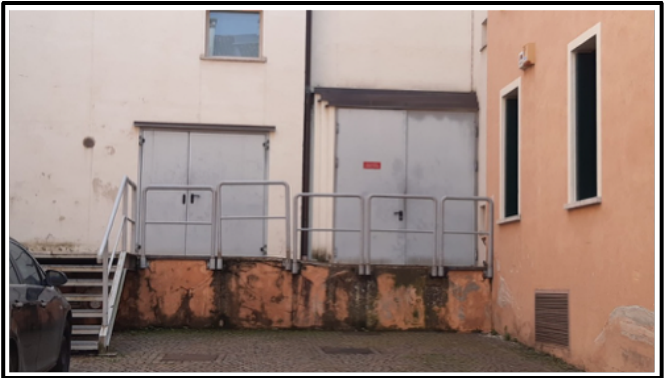
Figura 3 - ingresso palcoscenico tecnici e materiale
